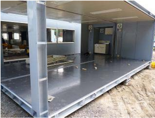
建設中の仮設診療所（装置設置3週間前）
