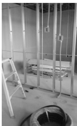
図1 職員図書室 カウンター付近 (7月14日撮影)
