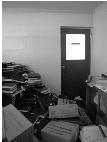
図6 4月11日の震度5の余震後
